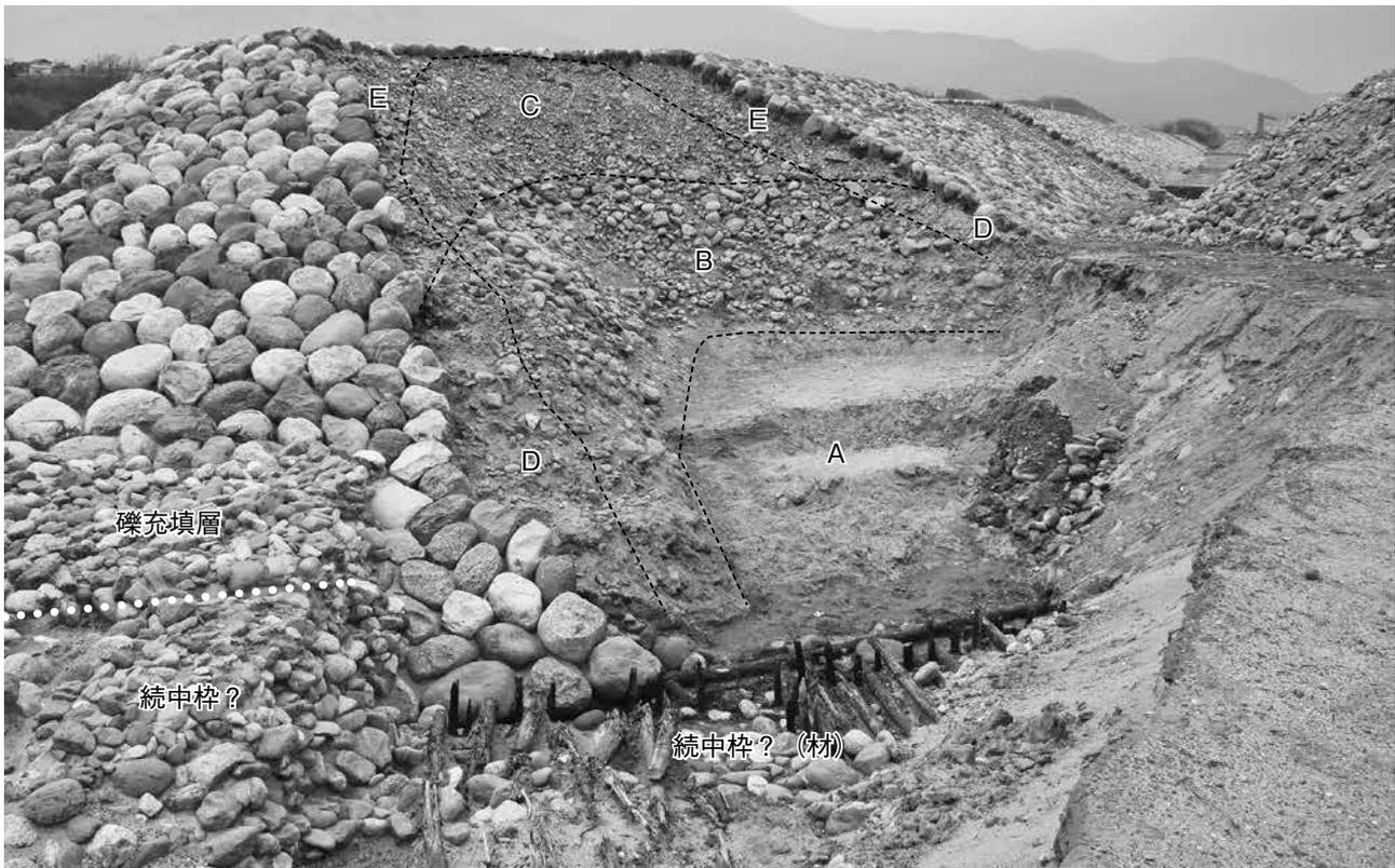
図1 古宮一番堤南端の構造〔A：地山（自然堆積層） B：堤体一段目 C：堤体二段目 D：裏込一段目 E：裏込二段目〕
